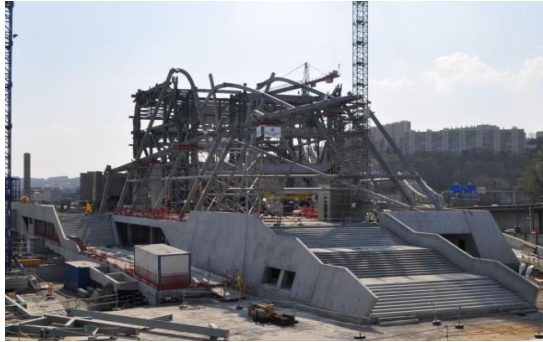
Début de construction du Musée des Confluences
